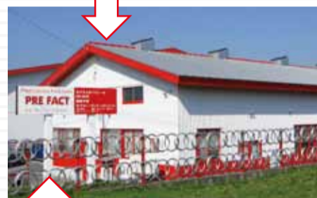
屋根・フェンスにも赤いラインが入るこだわり
